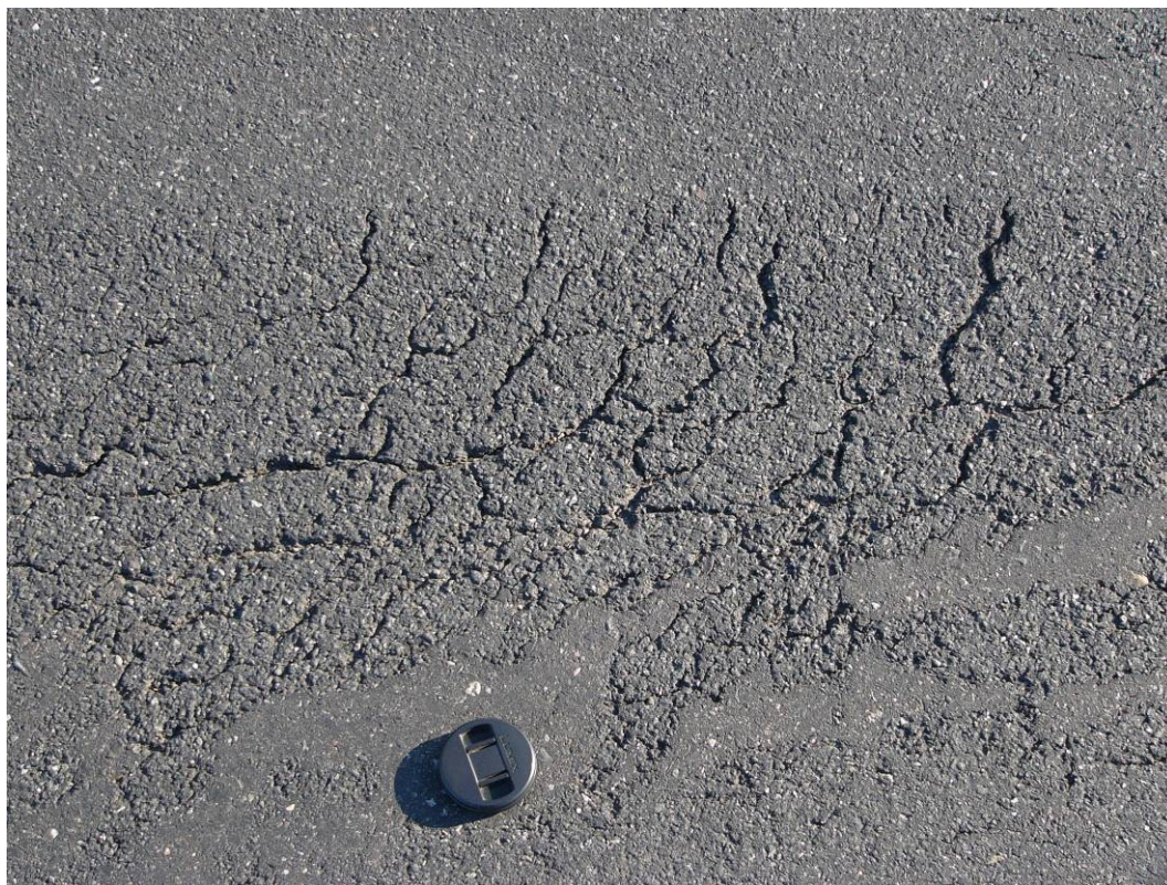
Obr. 5 – Kořenice - Pučery; mozaikové trhliny (10)
