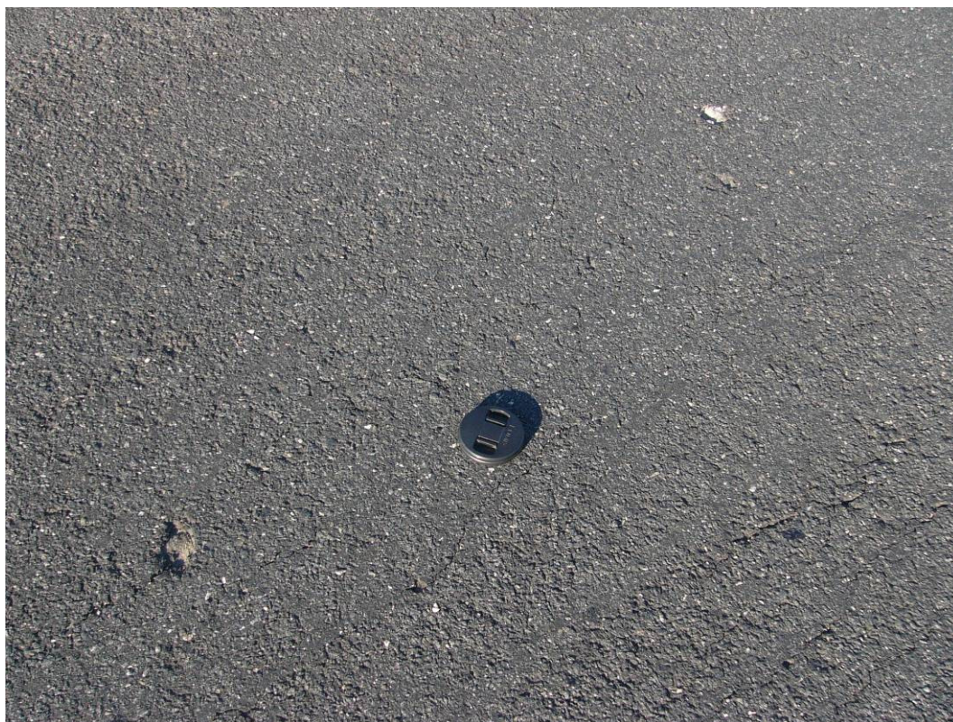
Obr. 4 – Kořenice - Pučery; ztráta asfaltového tmelu (06) doplněná ztrátou kameniva (05) a kavernami (03)
