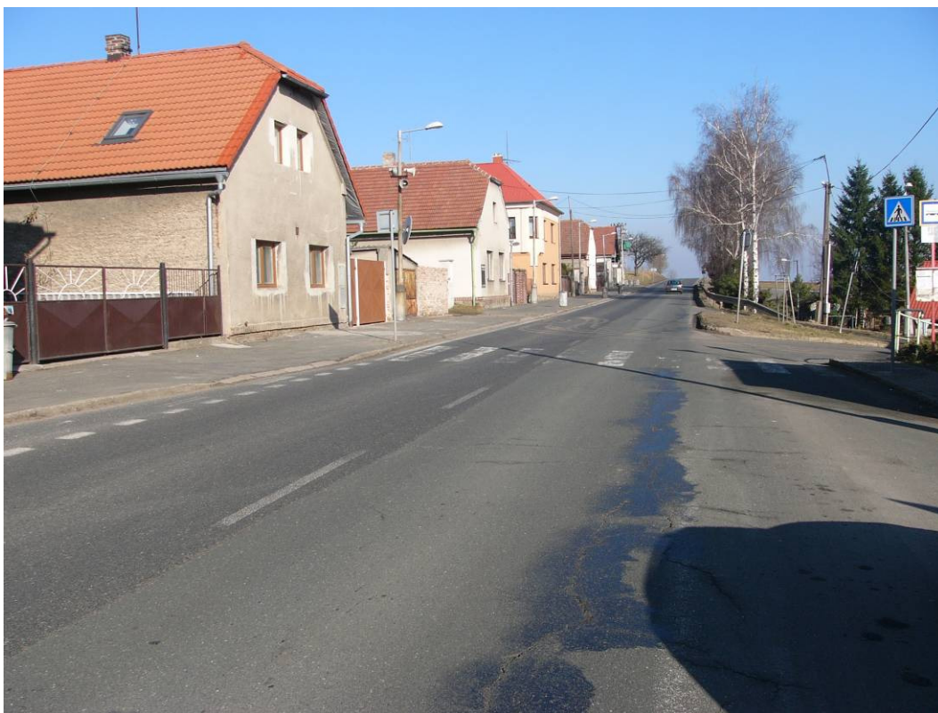
Obr. 3 – Kořenice; deformace a trhliny před zastávkou BUS
