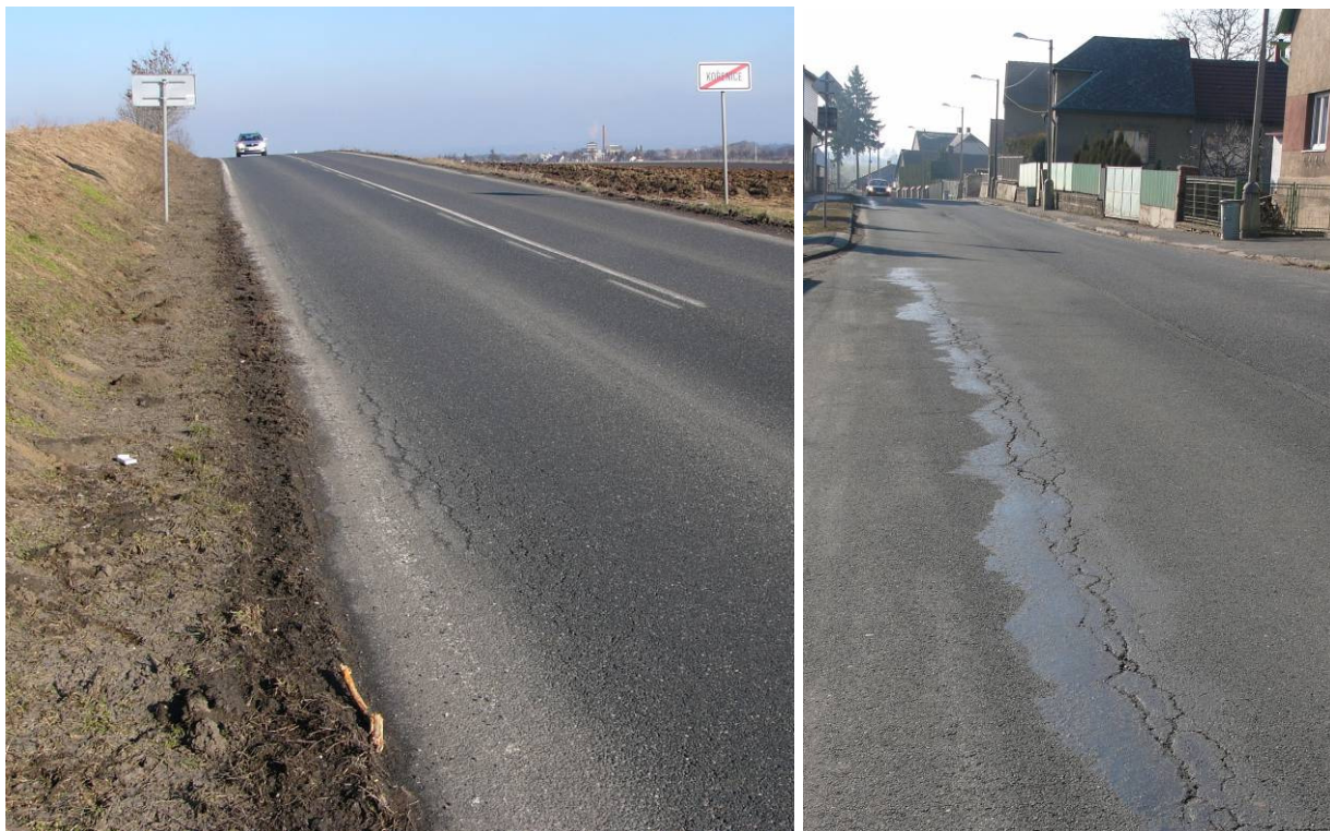
Obr. 2 – Kořenice; ukázka charakteristických poruch vlevo: rozvětvená podélná trhliny (15) přecházející do mozaikové trhliny (10) vpravo: rozvětvená podélná trhliny (15) přes vysprávkou (09)
