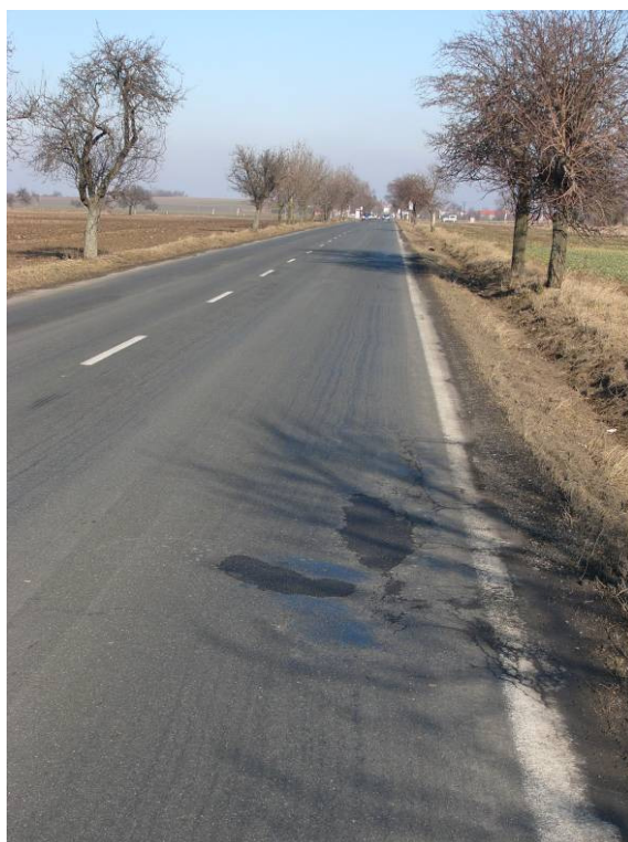
Obr. 7 – Kořenovice - Pučery; cca km 2,783 místní pokles (24) velkého rozsahu
