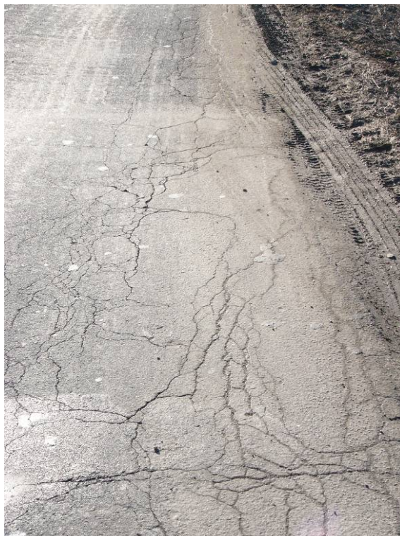
Obr. 6 – Kořenice - Pučery; cca km 2,188 kombinace mozaikových (10) a síťových trhlin (17)
