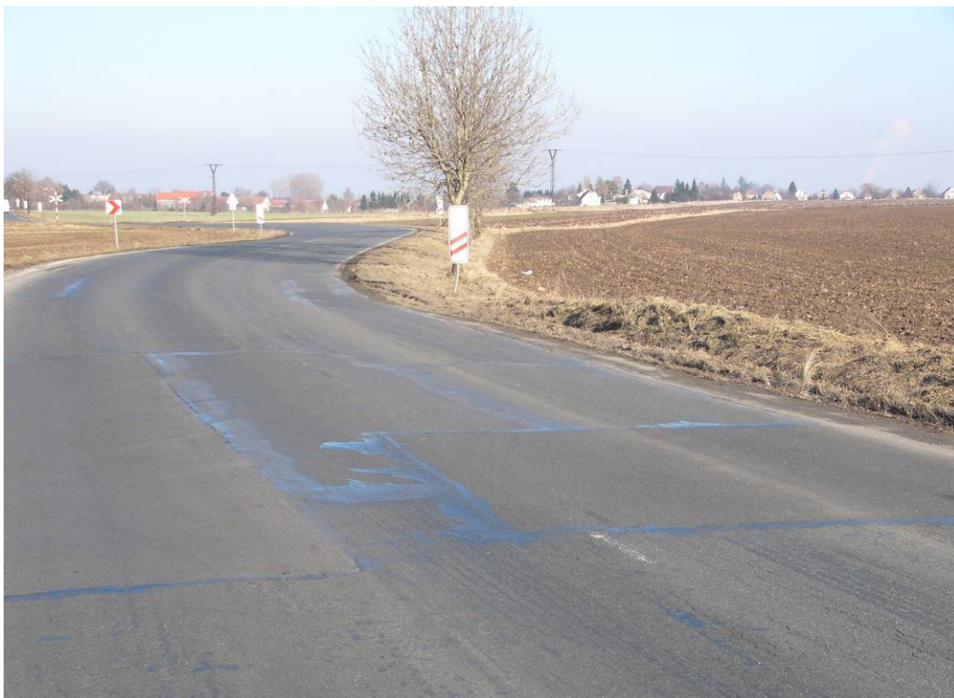
Obr. 9 – Kořenice - Pučery; vysprávky (09) za železničním přejezdem
