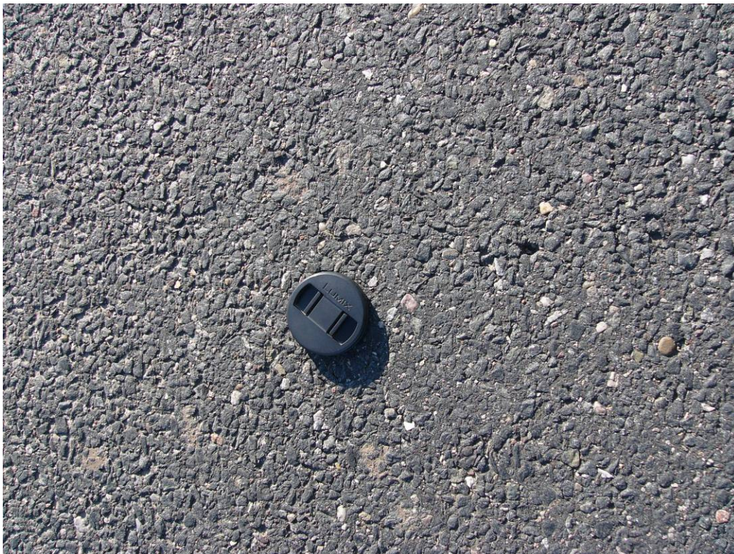
Obr. 1 – Kbílek – Kořenice; ukázka ztráty asfaltového tmelu (06)
