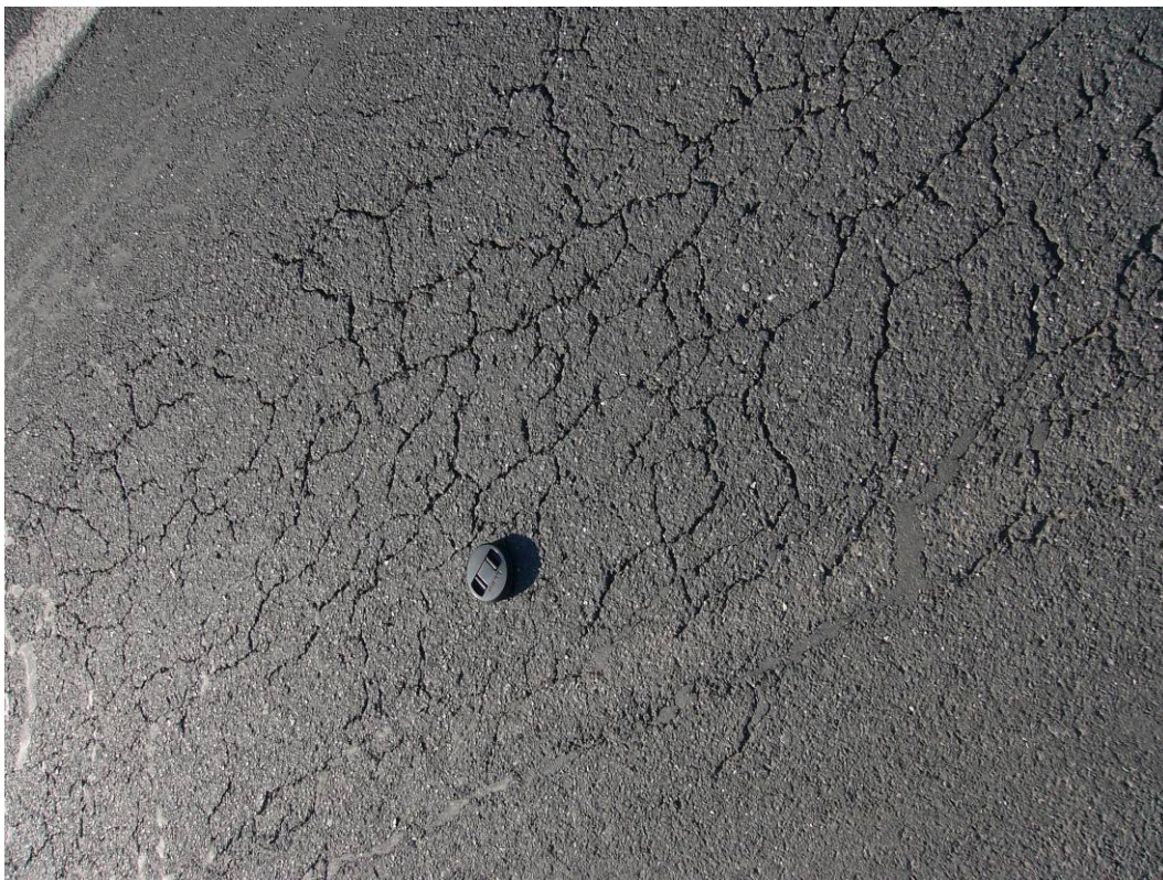
Obr. 10 – Pučery – silnice I/2; charakteristické mozaikové (10) až síťové (17) trhliny
